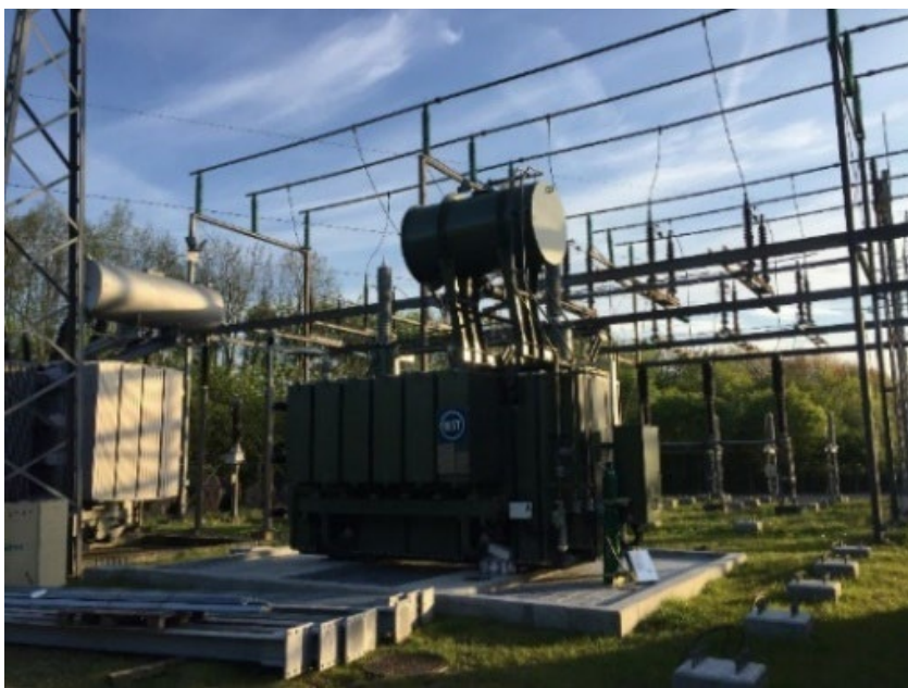
Eksempel på kompenseringspole der kompenserer for reaktiv effekt, der genereres i kabler og giver anledning til spændingsstigninger. Kompenseringspoler er nødvendige for at kunne holde spændingen indenfor de tilladte grænser for variationer i spændingen.
