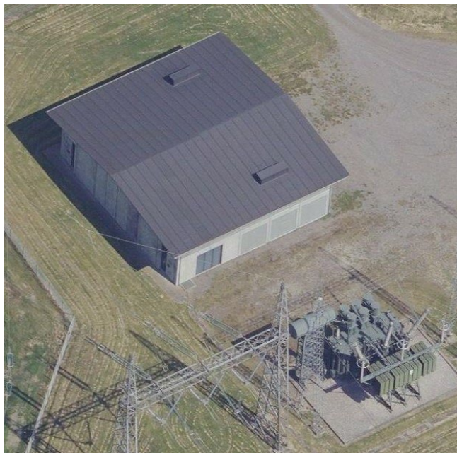
Eksempel på en GIS-bygning (GAS Insulated Switchgear). GIS-anlæg består af en lukket bygning indeholdende et gasisoleret kompakt indendørs koblingsanlæg samt en kompenseringspole.
